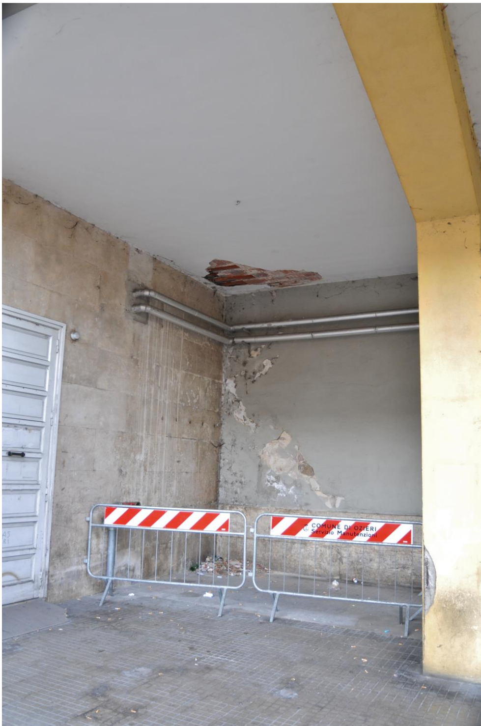
Figura 6 Portico di ingresso dalla via Roma – rifacimento intonaci e copriferro, intervento su solaio
