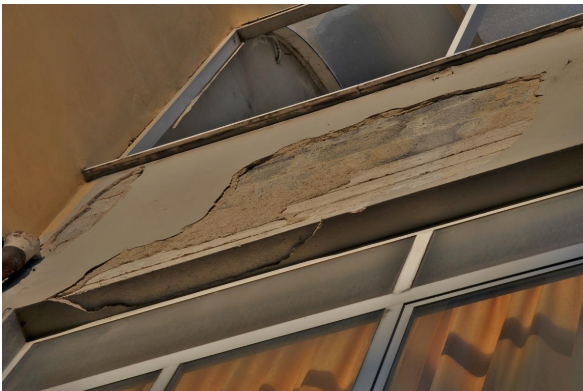
Figura 7 Ammaloramento intonaci in facciata da rifare
